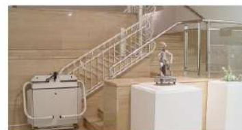
Plataforma salvaescaleras de acceso al atilido de la sala de exposiciones temporales A.
